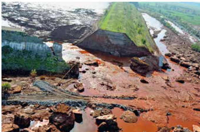
Az átszakadt vörösiszap-tározó, 2010. október 08., Kolontár (Forrás: Rácz Tünde)
